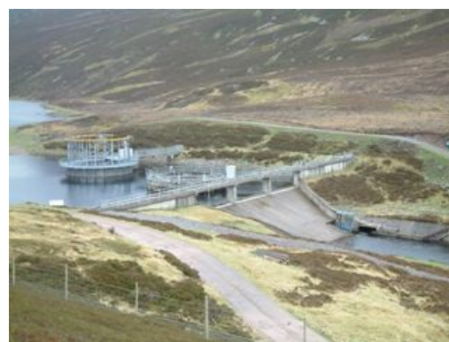
The SSE Dam at Loch An-t Seilich (River Tromie).
